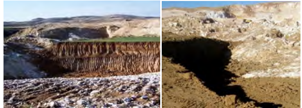
Şekil 7. Örtü kazısı sıyırma ve dolin temizliği
