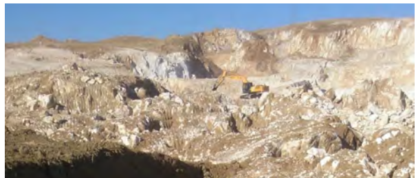
Şekil 8. Hidrolik ters kepeçlilerle dolin kazısı
