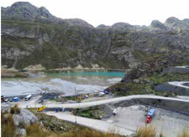
Güney Amerika'daki bir atık barajı
