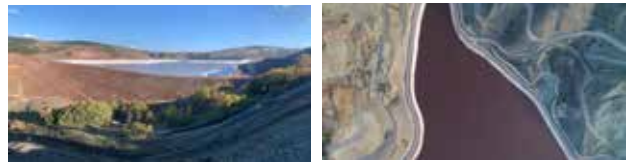
Şekil 4. Atık Depolama Tesisi (Atık Barajı)
