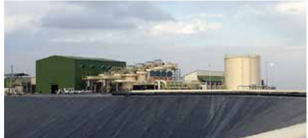
İvrindi Altın ve Gümüş Madeni Projesi, Altın Kazanım Tesisi, 2018
