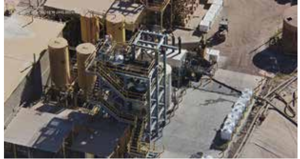
Mulas La Yaqui Grande Projesi, Altın Kazanım Tesisi, Meksika, 2024
