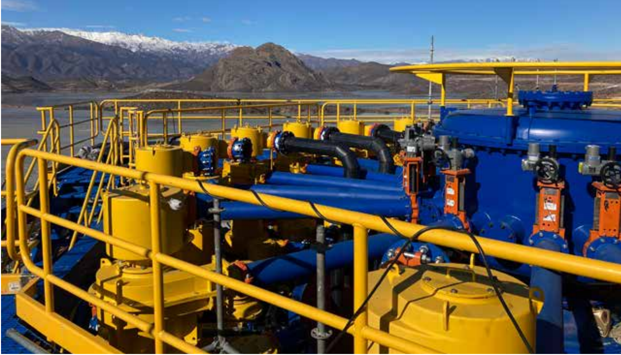
Güney Amerika'da bir atık tesisinde, Weir Cavex® DE Hidrosiklon teknolojisi
