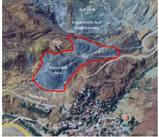
Şekil 8: Yıkımdan sonra Ergani Bakır İzabe alanı.
