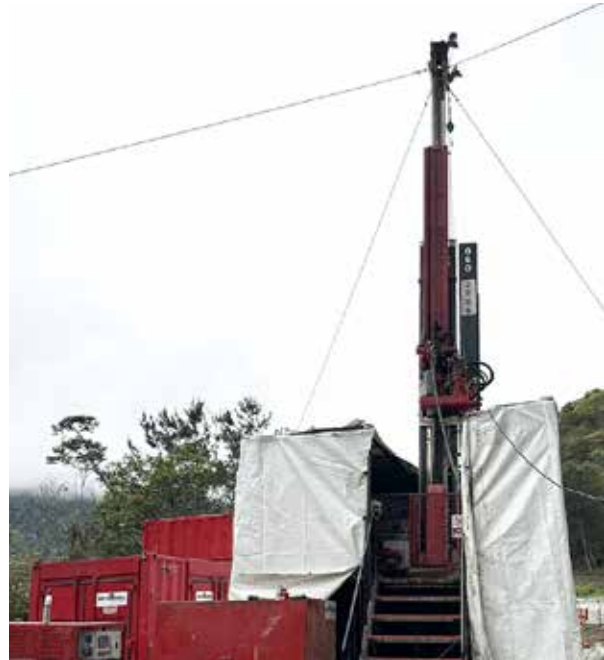
Fotoğraf 1. Sondaj makinesi ve ses bariyeri
