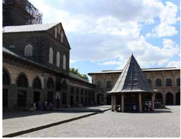
Diyarbakir Karacadağ Bazaltları: Tarihsel Dönemde Konutlar, İbadethaneler, Han, Hamam ve Kervansaraylarda Yapı taşı olarak ve Diyarbakir Surlarında geniş olarak kullanılmıştır. Günümüzde blok üretimi yapıp Diyarbakir'daki fabrikalarda işlenerek piyasaya verilmektedir.
