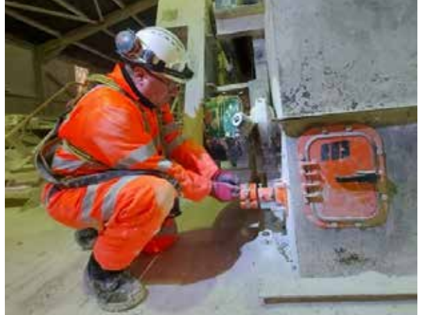
Bir Martin teknisyeni, bant sıyırıcı aşınmasını ve gerginliğini izlemek için bir uzaktan izleme sensörü takıyor.
