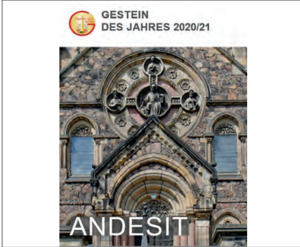
Andezit-Almanya'da Yılın Kayacı Afişi, Freital kentinin Döhlen semtindeki Luther Kilisesi'nin giriş portalında doğal taş olarak andezit kullanımı.
